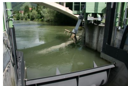
Abbildung 12: Kleinwasserkraftwerk; © DIE UMWELTBERATUNG
