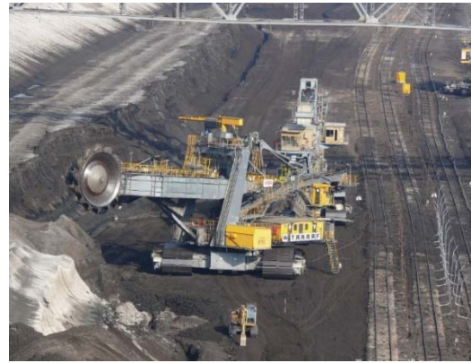
Abbildung 6: Schaufelradbagger und Mobilbagger im Tagebau Cottbus Nord; A. Gutwein CC BY-SA 3.0, Wikipedia
