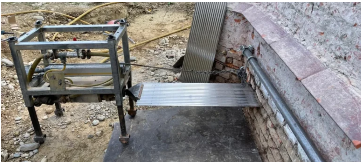
Abbildung 3: Anwendung Chromstahlblechverfahren
