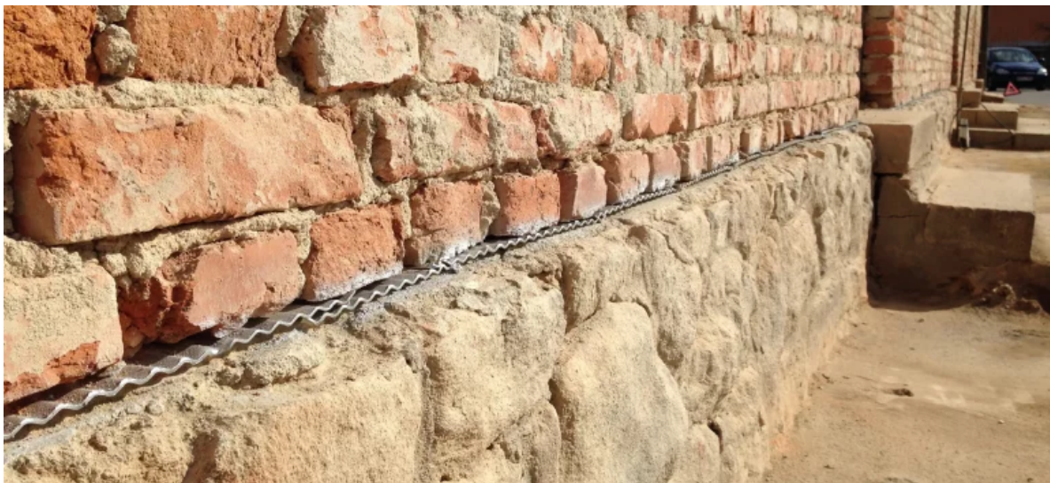
Abbildung 4: Anwendung Horizontalsperre
