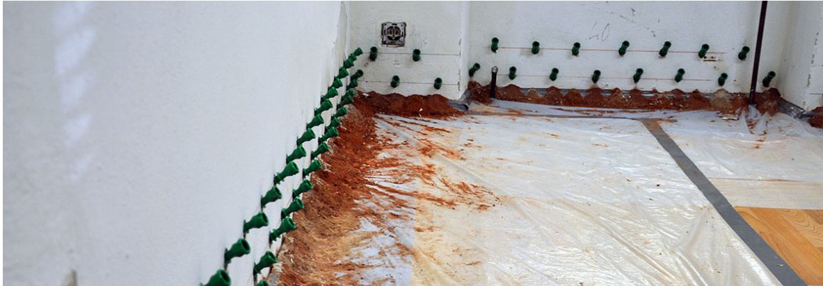
Abbildung 5: Anwendung Injektionsverfahren
