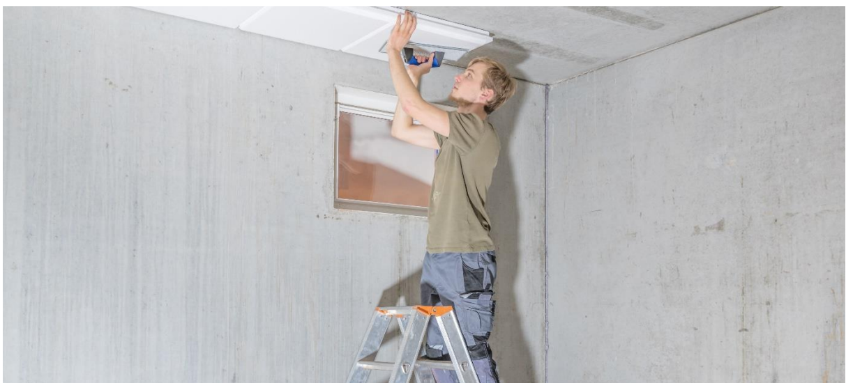
Abbildung 1: Kellerdämmung anbringen
