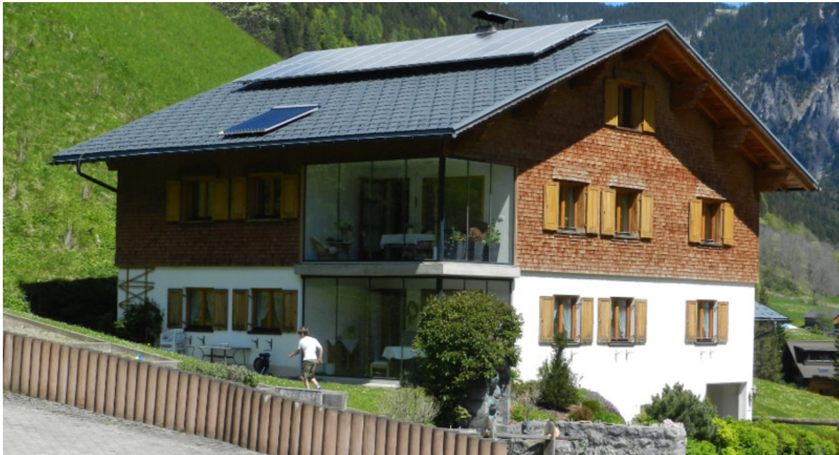
Bild: IB Schallert OG, Innertal 10 , 6708 Brand, Vorarlberg
